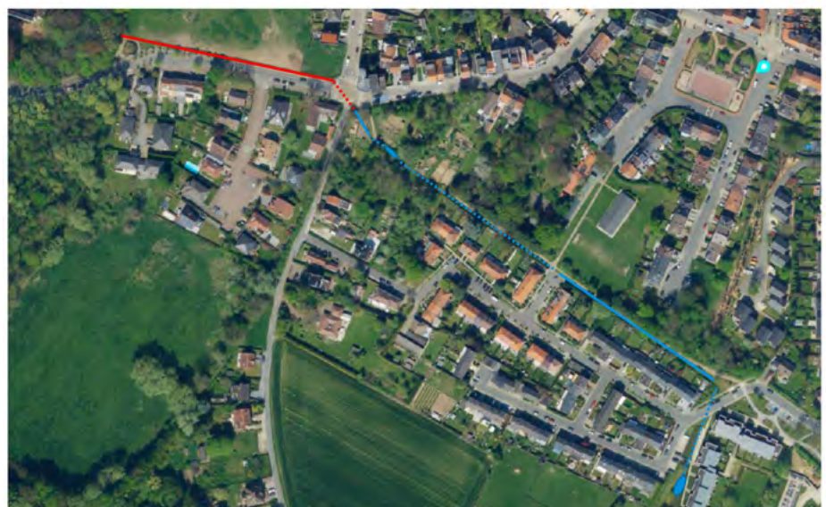
> Berchem-Sainte-Agathe : Etude et travaux d'aménagement de la liaison au Kattebroek
